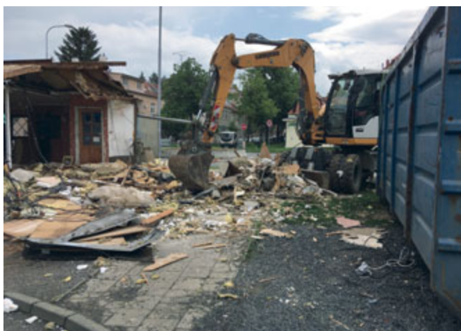
Zahájení rekonstrukce – staré uvolňuje místo novému
